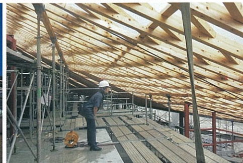
施工時の様子。梁は上弦梁と下弦梁を格子状に組むことで、たわみが設計時の計算上の数値とびつたり合った。
