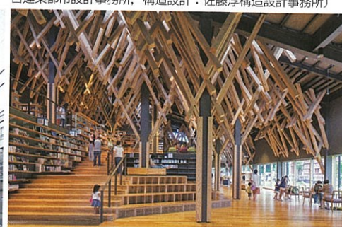
「ゆずはら雲の上の図書館 / YURURIゆずはら」交流広場。天井は120mm角のスキ材で構成された木組み。(設計：隈研吾建築都市設計事務所、構造設計：佐藤淳構造設計事務所)
