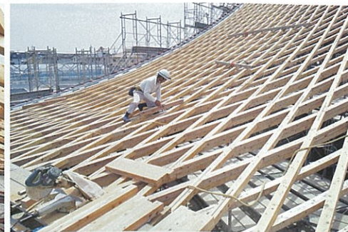
施工時の大工の様子。
